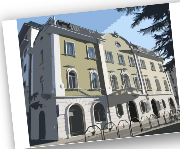
Palazzo Alberti - Posa
